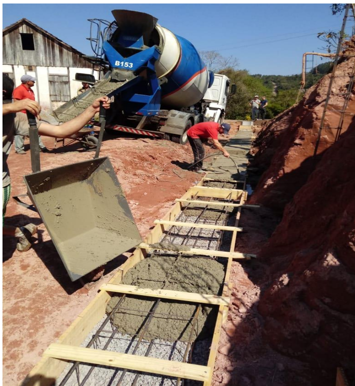
Figura 9 - Exemplo de concretagem de base de muros.
