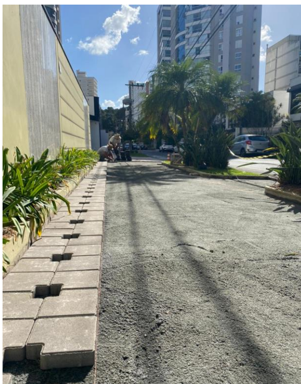
Figura 6 - Exemplo execução de piso intertravado sobre pó de pedra.
